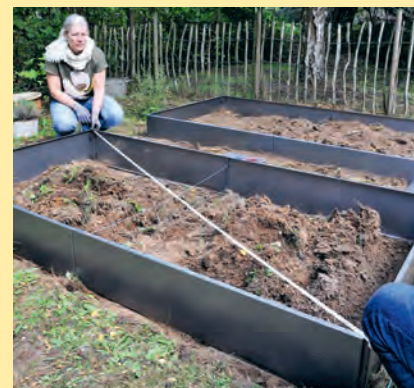
4 Her tages et skråt tværmål for at sikre, at bedet er sat i vinkel.
